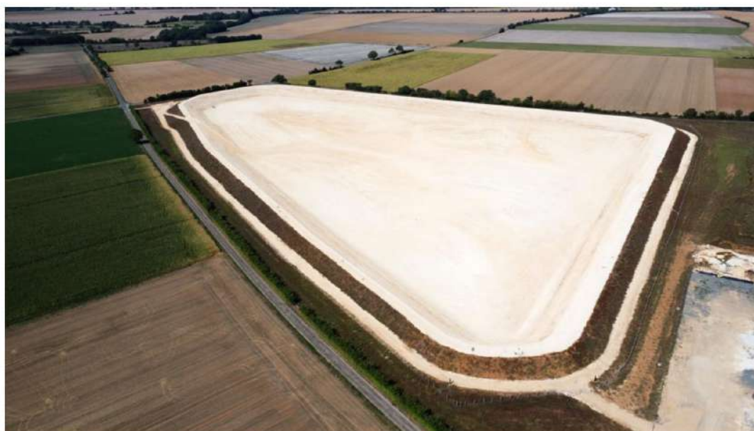
Vue par drone de l'état d'avancement la retenue SEV15 et de l'aire d'expertise de cette levée de contraintes – Source : Photo drone JF SEROT - Août 2023
