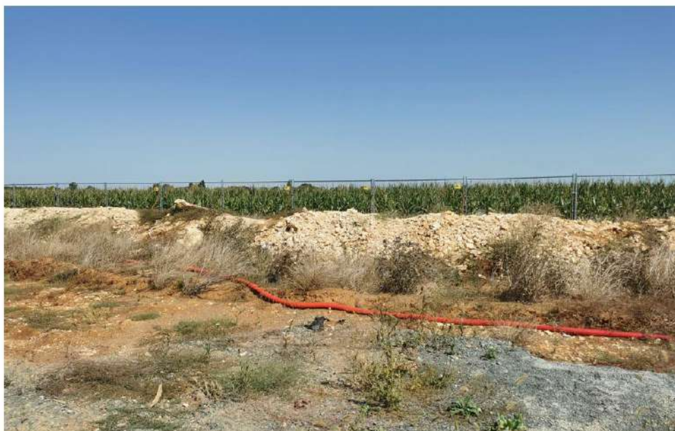
Merlon et parcelle en maïs limitrophe à la base vie de chantier – Source photo : JF SEROT 2023
