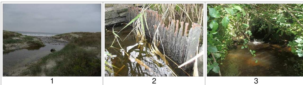
Obstacles sur le St Vio: 1 :brèche active ; 2 :ancienne pêcherie de St Vio, ouvrage en mauvais état, non problématique ; 3:buse mal calé, chute et lame d'eau insuffisante malgré la présence d'un pré-seuil.
